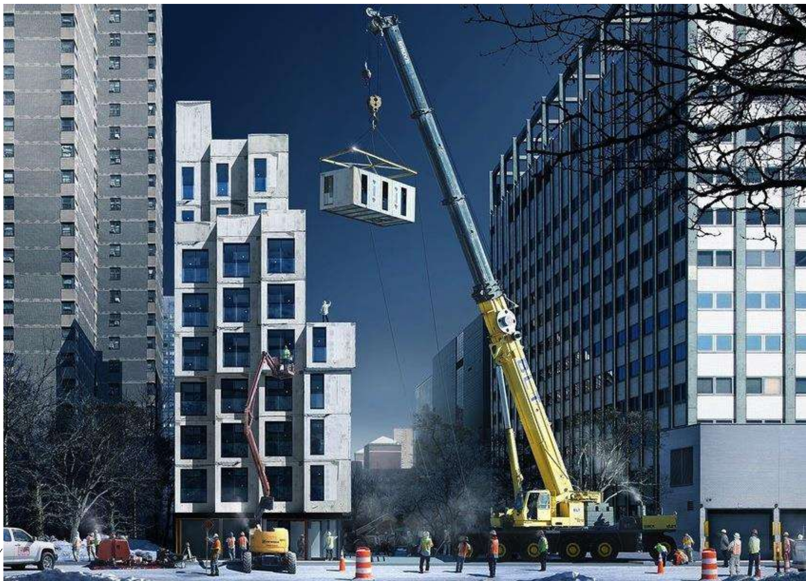
Mise en place d'un module, 4857 Broadway, NY (Gluck + et Stack Modular) collection Carlo Carbone
