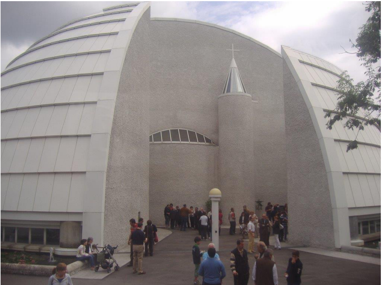
Fig.8 Vista del exterior donde no se percibe, sus conectores estructurales, en la Fachada.
