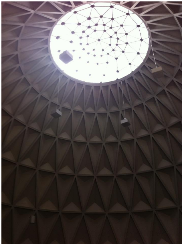
Fig.41 La estructura del techo tiene forma parabólica y fue revestida por una lámina de acero inoxidable resistente.
