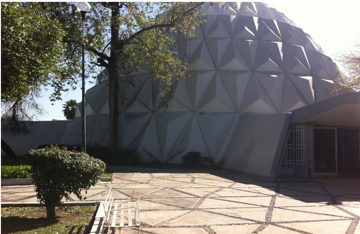
Fig.42 Exterior del edificio religioso con su singularidad estructural.
