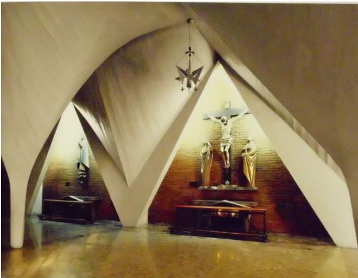
Fig.10 En su interior de la Iglesia, la estructura es la que define el espacio arquitectónico.
