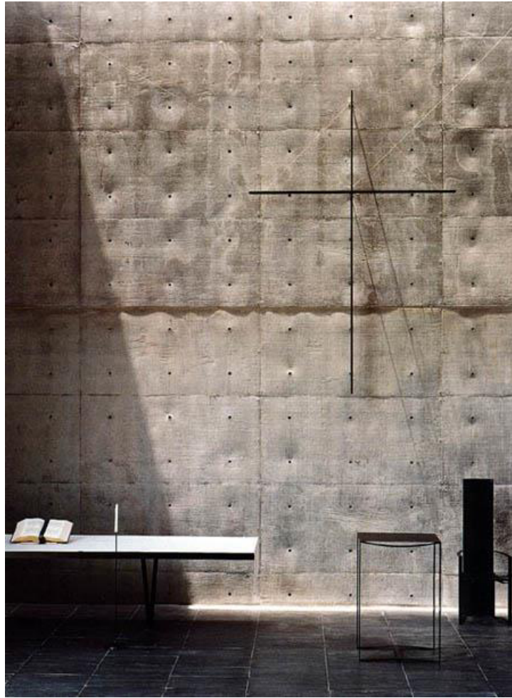
Fig.13 La Capilla en el monte Rokko en sus paredes presentan la calidad del hormigón expuesto.
