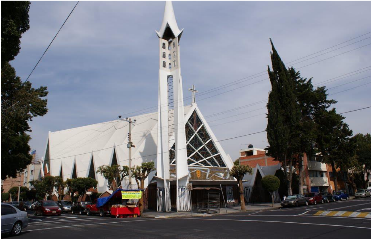
Fig.9 La iglesia de la Medalla Milagrosa, eleva a la arquitectura latina cuya estructura está constituida por secciones paraboloides hiperbólicos de cantos rectos.
