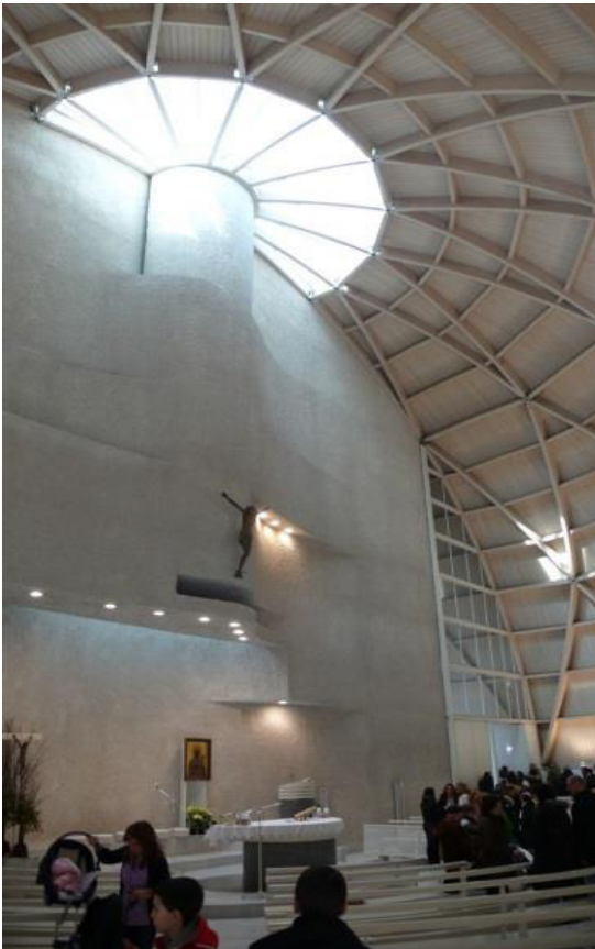
Fig.7La Iglesia de Massimiliano Kolbe, vista en su interior sobresale su revestimiento de madera, pintado de blanco.
