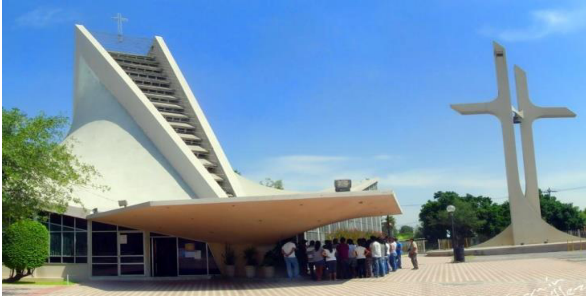
Fig.22 La Iglesia de San José Obrero, emplea el arq. De la Mora la técnica de cascarón de concreto.
