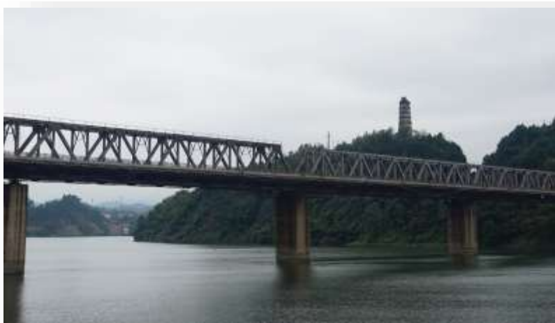
焦柳铁路上的沅江大桥
