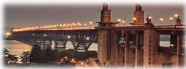
京沪铁路南京长江大桥
