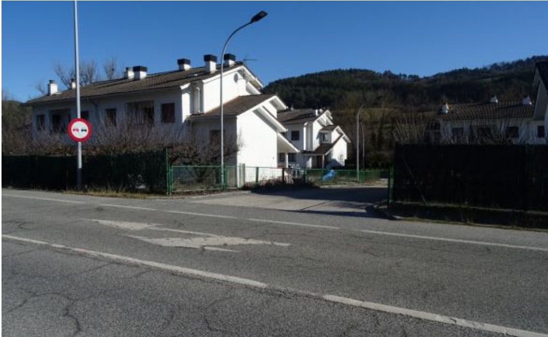
Entrada rodada a calle Río Arga
