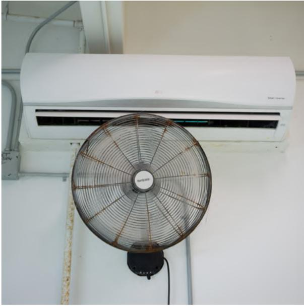
**Un ventilador de circulación oscilante** distribuye el aire frío de un acondicionador de aire.
