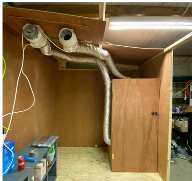
**Paso 3:** Coloca el ventilador en lo alto de una pared o cerca
