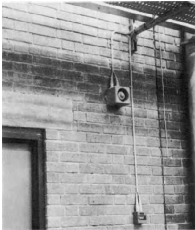
ပုံ ၆.၁၀ Fire alarm point နှင့် siren တို့အား MI Cable ဖြင့် ဝါယာသွယ်တန်းထားပုံ (BP Ltd)
