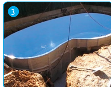
3 Colocación Placing
