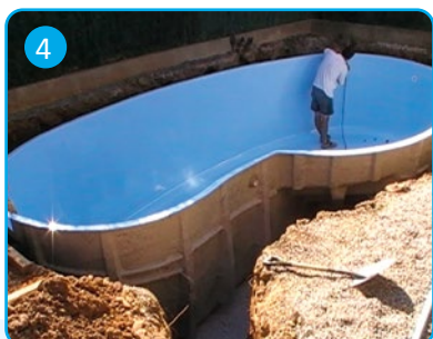
4 Puesta a nivel Levelling
