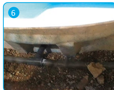
6 Conducciones periféricas Peripheral pipes
