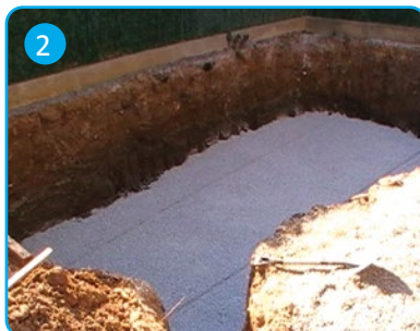
2 Preparación del terreno Ground preparing
