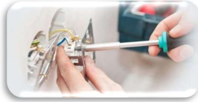
Elektrik Tesisat İşleri
