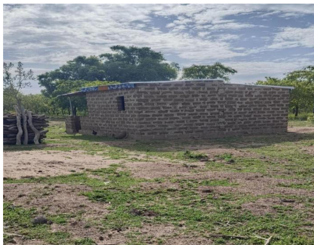
Photo 3 : Maison en construction d'un docker originaire de la région des Cascades, sud-ouest Burkina Faso ( cliché de Gnakabi, 2025 ).
