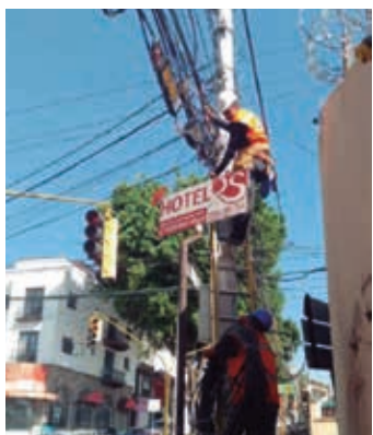
Tendido de Fibra Óptica
