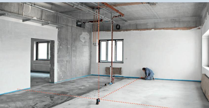
Precisión de  $\pm 0,3$  mm/m para una transmisión precisa de ángulos rectos y puntos de referencia del suelo al techo
