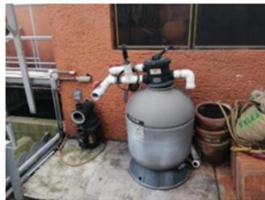
Remplazo de filtros
