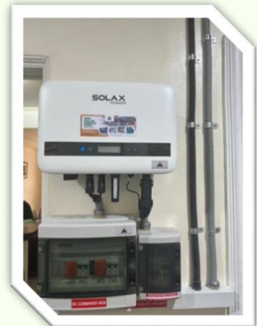
Mga larawan ng Installed Grid Tie Solar Power System
