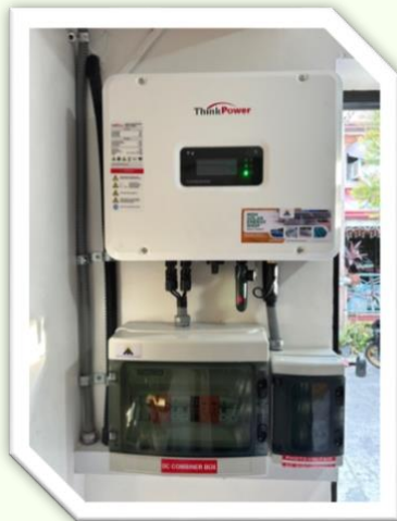
Mga larawan ng Installed Grid Tie Solar Power System
