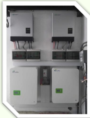
Mga larawan ng Installed Hybrid Solar Power System using LifePO4 Batteries
