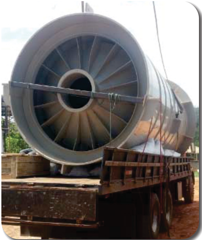
Reator UASB 25.000litros
