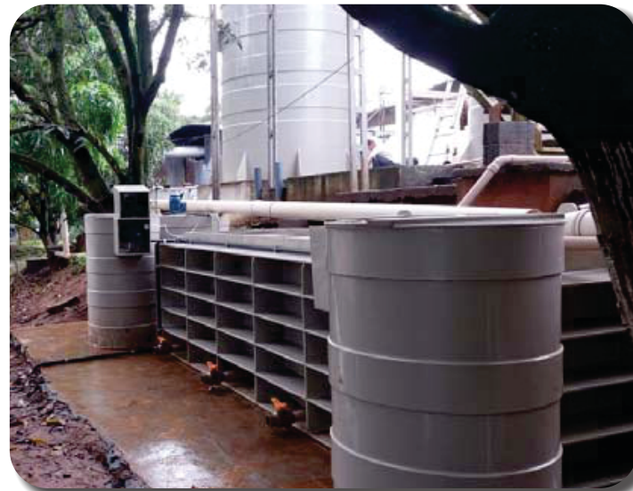
Tratamento Final Desinfecção e Ajuste Automático de pH
