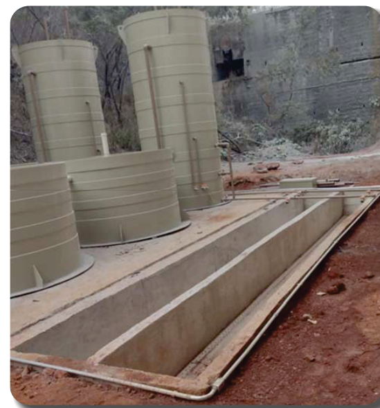
Estação de esgoto
