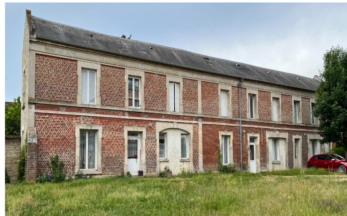
Batiment B : Façade Avant
