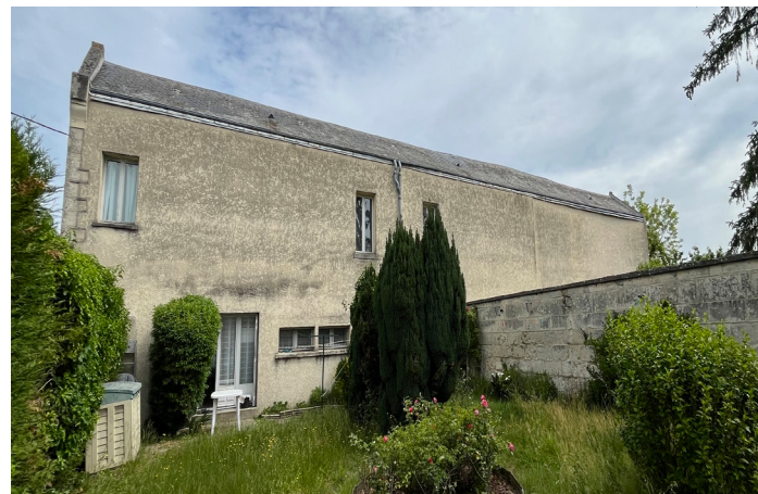
Batiment B : Façade Arrière
