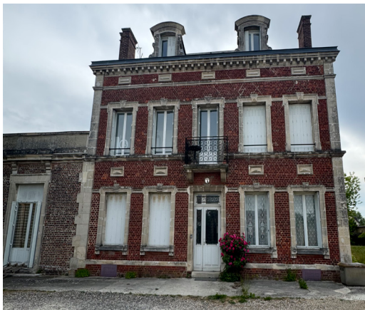
Batiment A : Façade Avant
