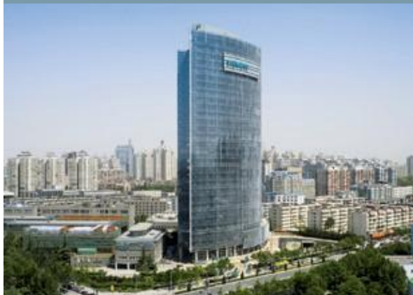
Siemens data center in Beijing
