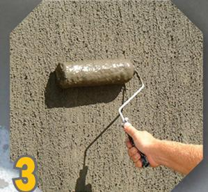
**3** Aplicar **BOND KOTE**, asegurando que la aplicación sea uniforme en espesor y textura
