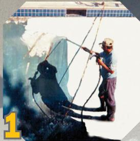
**1** Limpie el sustrato. Retire el yeso suelto y delaminado y los contaminantes.
