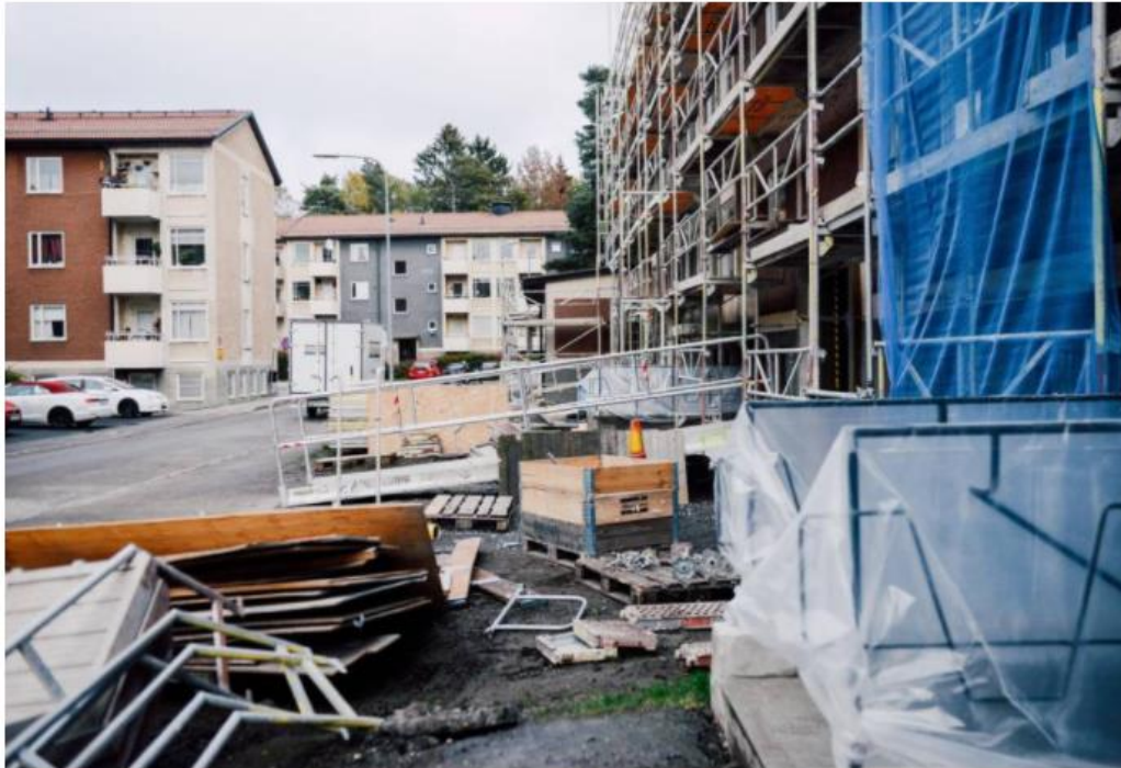
Renovering. Fönsterbytet är en del av en större fasadrenovering som pågått sedan i juni. Så här såg det ut på platsen i oktober. Foto: Sacharias Källdén
