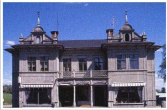
Foto: Gamla pappershandeln i Edsbyn som valde att energieffektivisera genom att sätta in en luftvärmepump som komplementvärme till den tidigare direkteten. Bilden ägs av Länsmuseum Gävleberg. Fotograf: Michael Ahne.
