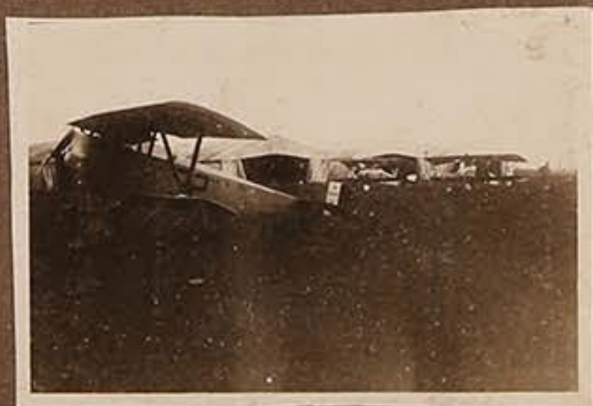
18 Meter Nieuports Issoudun Nov. 1917
