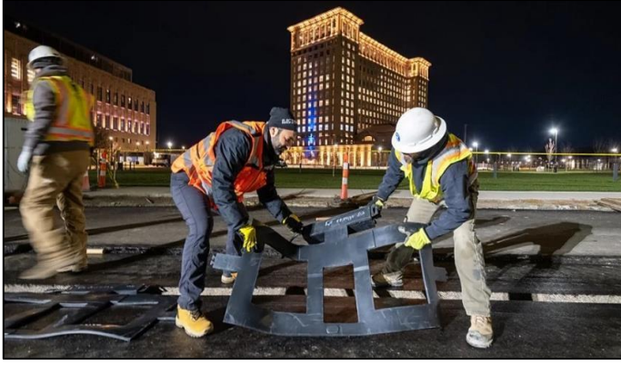
Şekil 4. New York elektrikli yol yapım aşaması (Paris, 2024).
