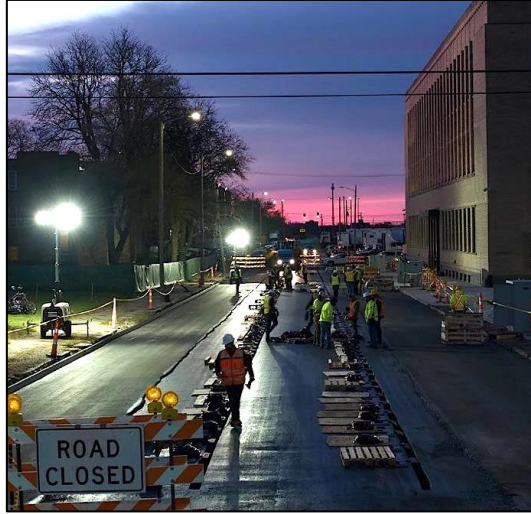
Şekil 5. New York elektrikli yol yapım aşaması (Paris, 2024).
