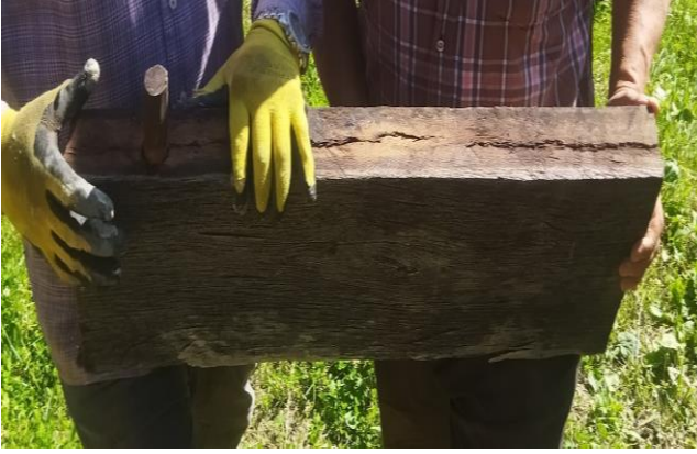
Şekil 10. Ahşap kavela (zıvana), (Veysel Tokdemir Kişisel Arşivi, 2023).
