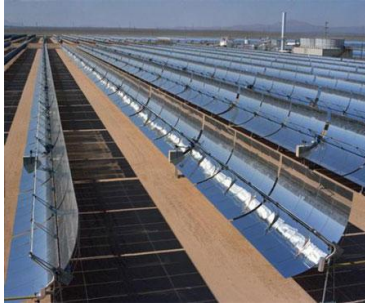
Şekil 2. Parabolik güneş santrallerinde yoğunlaştırıcı dizilişi (Kearney, 2007)
