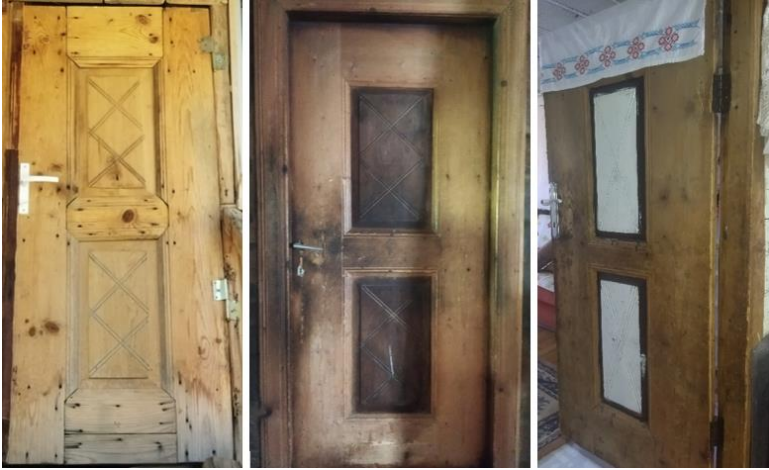
Şekil 8.İç Mekân Kapıları, (Veysel Tokdemir Kişisel Arşivi, 2023).
