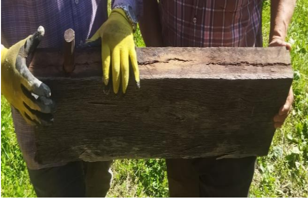
Şekil 10. Ahşap kavela (zıvana), (Veysel Tokdemir Kişisel Arşivi, 2023).
