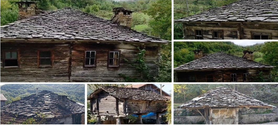
Şekil 11. Kayrak taşı çatı örtüsü (Veysel Tokdemir Kişisel Arşivi, 2023).
