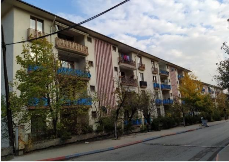
Şekil 13. Beyaz Apartmanlar, Yenışehir/Karabük (Ulusoy Evlekoğlu Arşivi, 2020).
