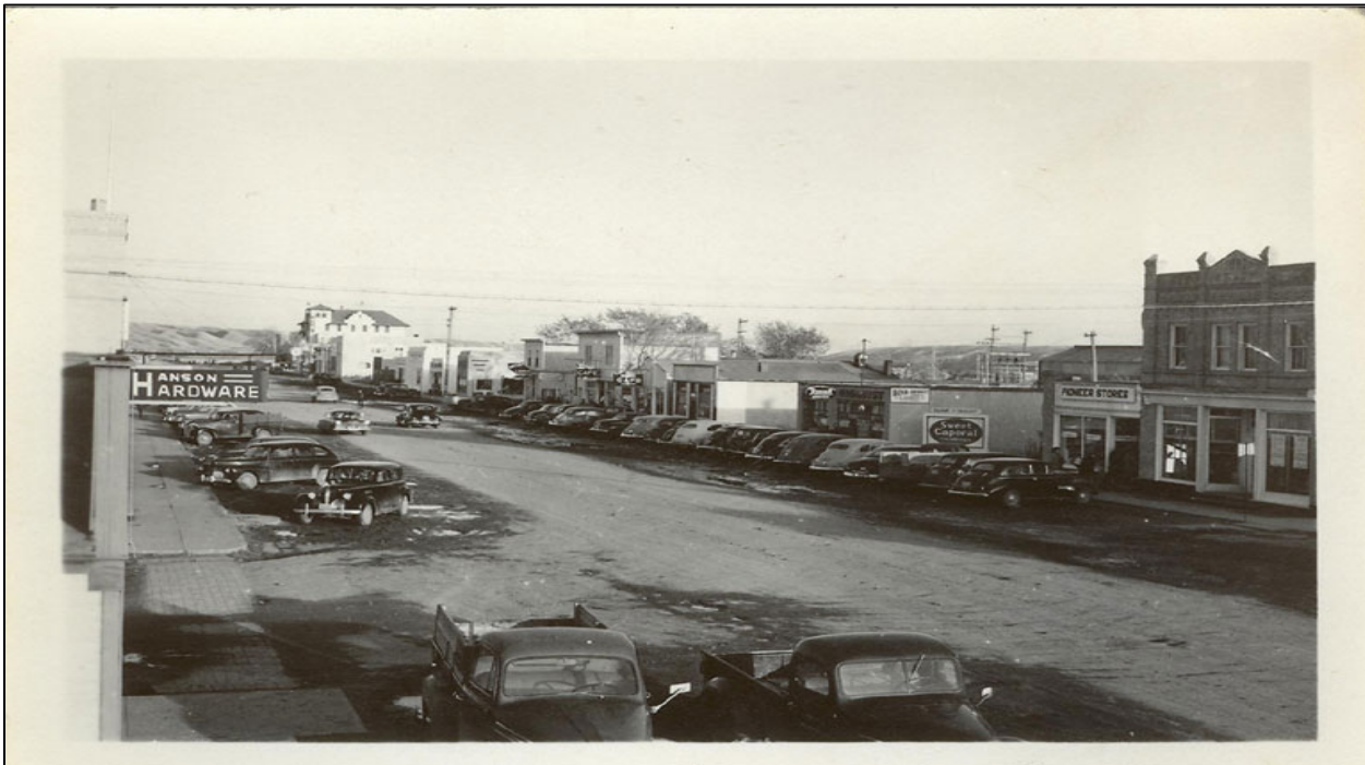
History View of Broadway Avenue in Fort Qu'Appelle
