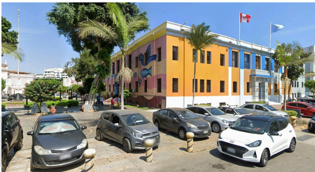
Fig. 12. Esquina del Centro Cultural Juvenil, estado actual
