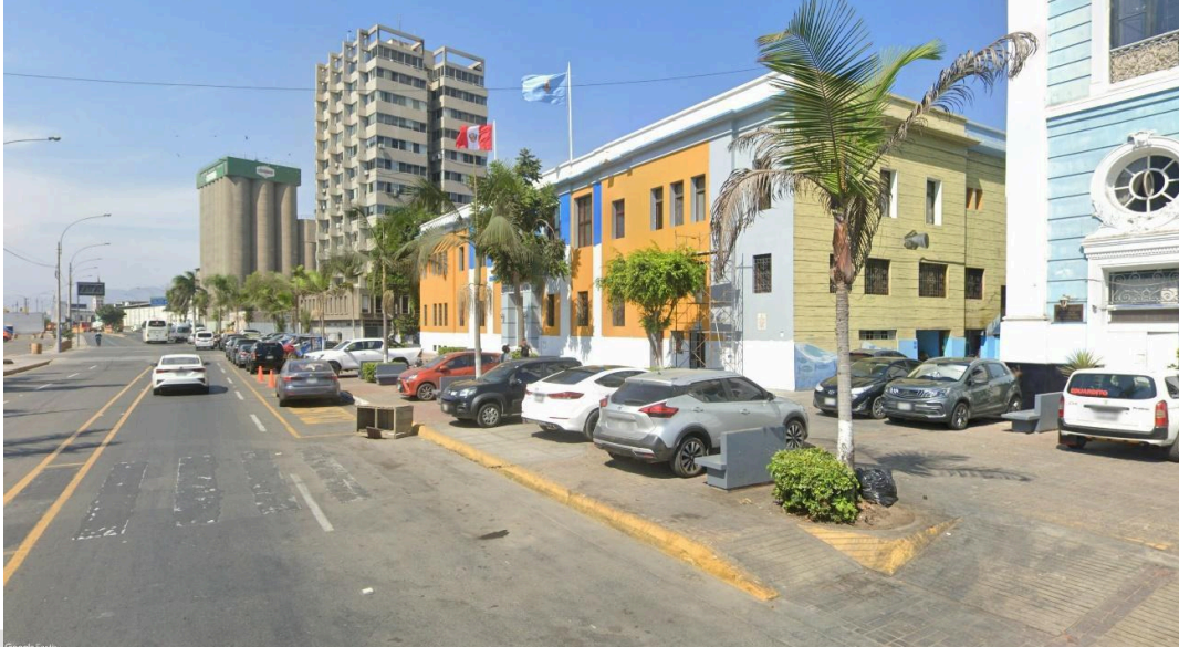
Fig. 9. Esquina del Centro Cultural Juvenil, estado actual
