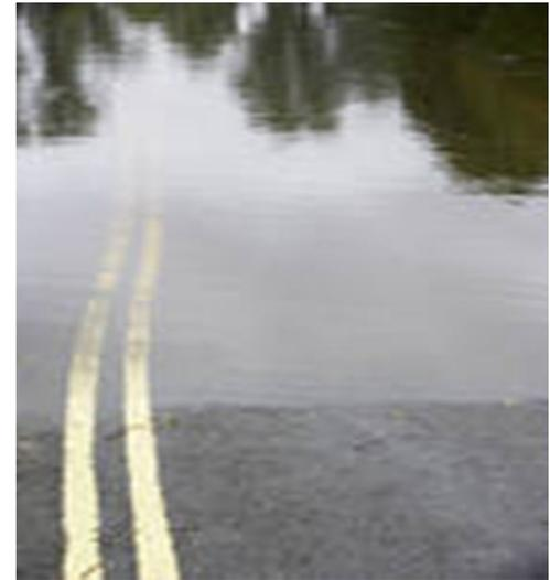
**Efecto Lambert:** debido a las reflexiones internas que se producen en la interfase agua-aire cuando sobre una superficie rugosa (lambertiana: de reflectividad uniforme) existe una película de agua. Este fenómeno, en todo caso, ayuda a mejorar el contraste de las marcas viales
