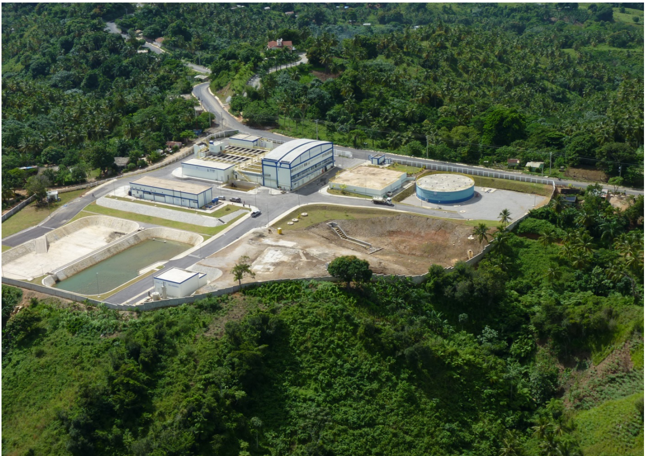
PLANTA DE TRATAMIENTO DEL ACUEDUCTO DE SAMANÁ
