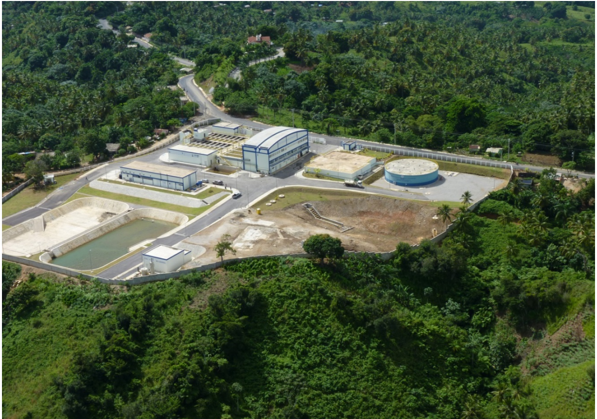
PLANTA DE TRATAMIENTO ACUEDUCTO DE SAMANÁ
