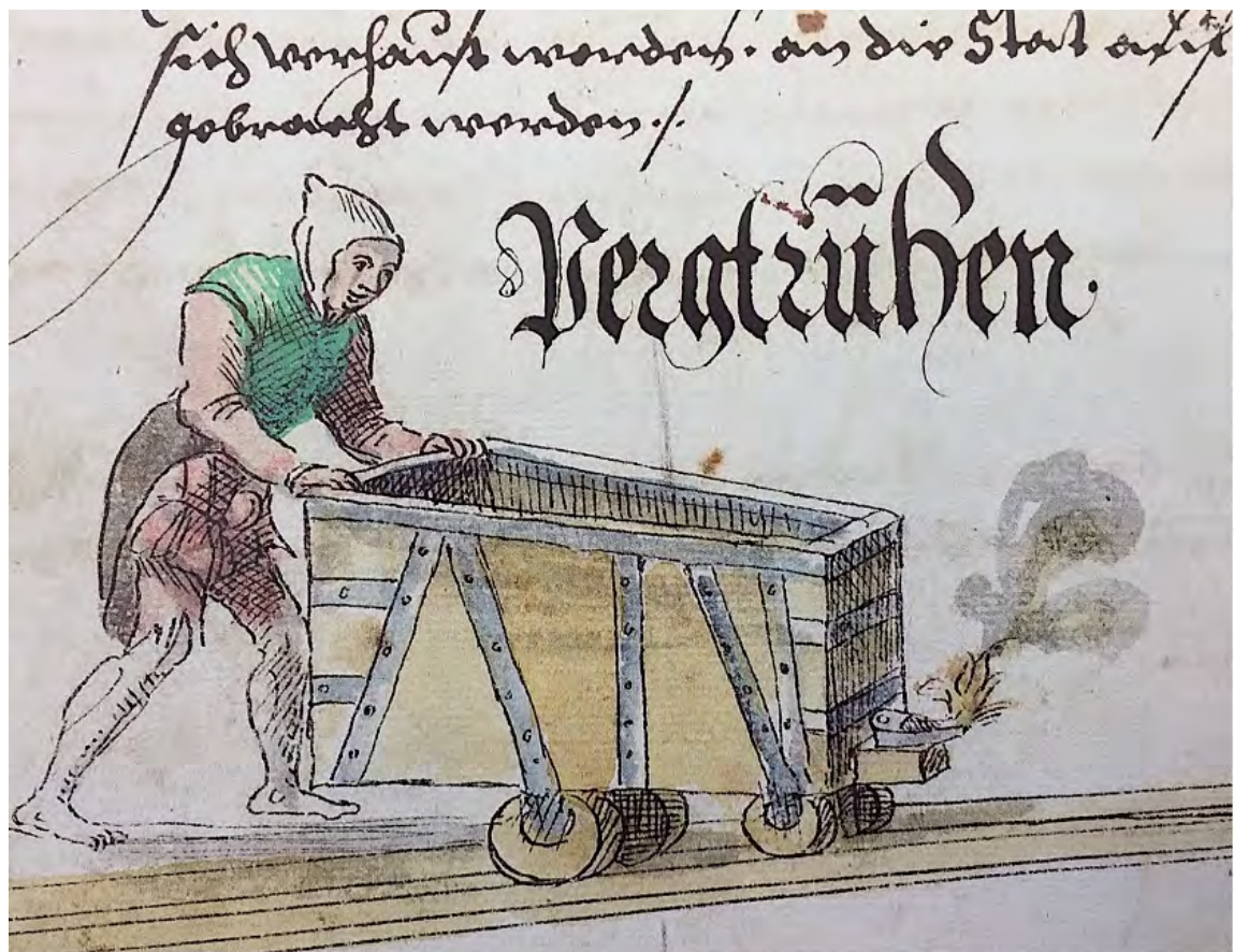
Abb. 19: Hölzerner Spurnagel-Hunt ( Pergruhen ), der auf einer Bohlenbahn (Huntegestänge oder Huntelauf) bewegt wurde. Im Zwischenraum zwischen den Bohlen griff der Leitnagel ein. Die flache Schalenlampe an der Stirnseite des Hunts ist auf einem Vorsprung angebracht, vermutlich durch Aufstecken der Griffülle auf einen senkrecht zur Auflagefläche angebrachten Nagel oder hölzernen Pflock. Schwazer Bergbaurevier, Mitte 16. Jh., Abbildung aus »1556 Perkwerch etc.«, Bochumer Entwurf von 1554. (Montanhistorisches Dokumentationszentrum [montan.dok] beim Deutschen Bergbau-Museum Bochum 040003313001, Ausschnittbearbeitung: Hartwig Büttner)
