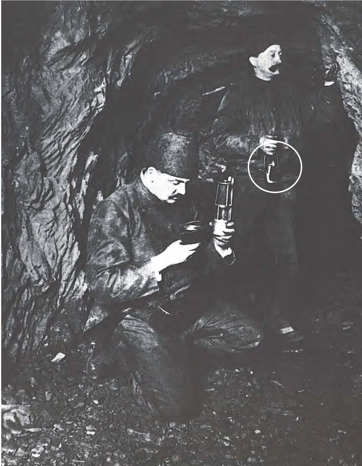
Abb. 15 | Harzer Markscheider beim Ablesen eines Kompasses im Kaiser-Wilhelm-Schacht, Clausthal, um 1900. Die in der linken Hand gehaltene Sicherheitslampe hat anstelle des Hakens am Gestelldach einen Handgriff angebracht (vgl. Abb. 17). Der Markscheider-Gehilfe führt eine typische mittelgroße Harzer Handschelle (Kreismarkierung) 14 , aus: Borges, 1982, S. 11
