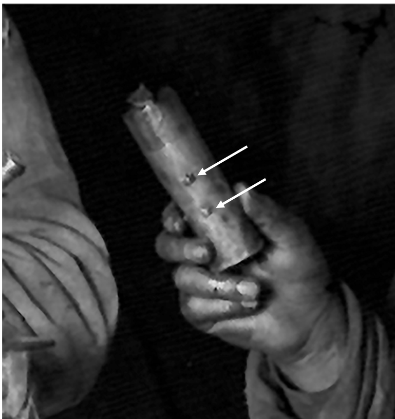
Abb. 10 | Ausschnitt-Vergrößerung aus Abb. 2. Es handelt sich bei dieser Lampe mit oben senkrecht ausgeführter Dochttüle um eine typische Markscheiderlampe. Ein ursprünglich vorhanden gewesener seitlich angebrachter Handgriff wurde bei dieser Lampe offensichtlich entfernt oder ist verloren gegangen (Pfeilmarkierungen: Griffbefestigungen am Lampenkorpus)
