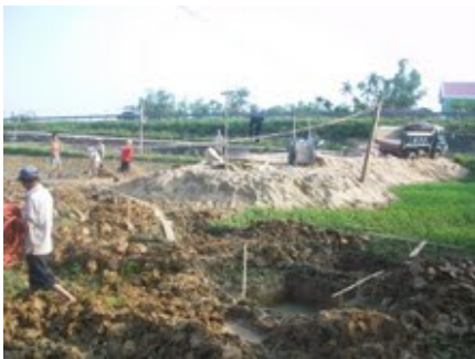
Giai đoạn 1: đổ đất nền và chuẩn bị...
