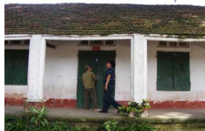
Cận cảnh với mái ngói rêu phong, xà kèo gần sụp đổ...
