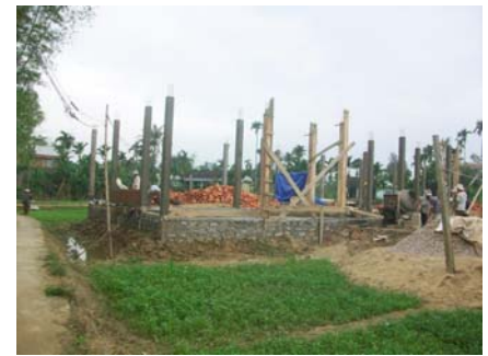
Giai đoạn 2: Xây nền và dựng cột tường.
