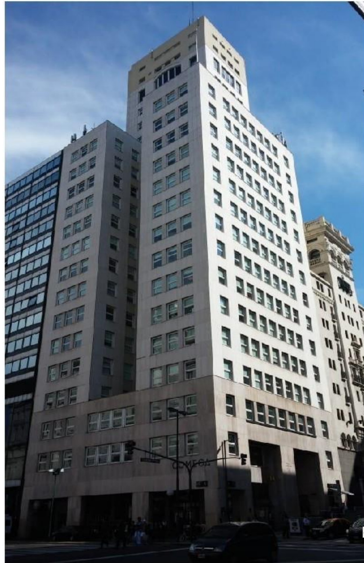
EDIFICIO COMEGA PUESTA EN VALOR
