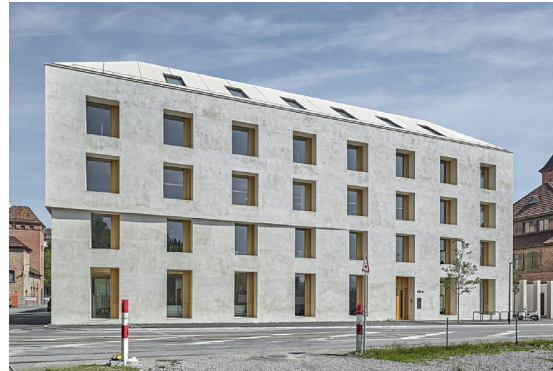
15. ábra: Baumschlager Eberle, 2226 irodaház
