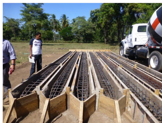
FABRICACION DE PILOTES PARA HINCAR
