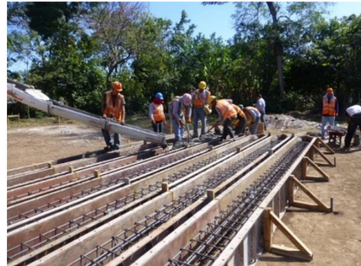
FABRICACION DE PILOTES PARA HINCAR IN SITU
