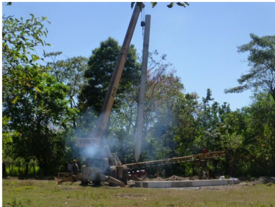
MONTAJE DE PILOTES HINCADOS
