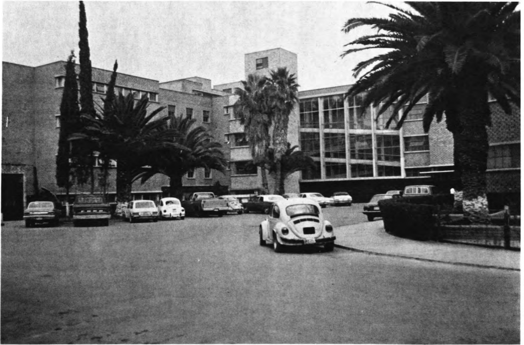
IMAGEN ACTUAL DEL HOSPITAL UNIVERSITARIO DE SALTILLO.
