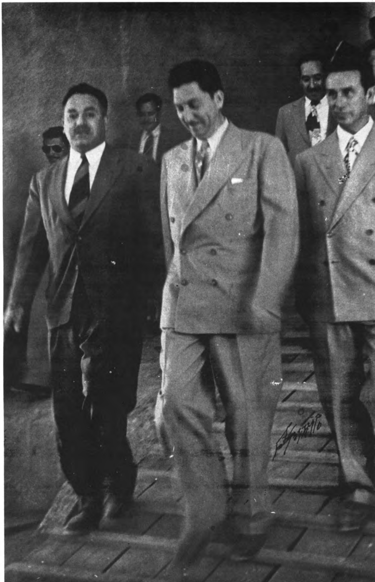
EN EL PROCESO de la edificación, el Dr. Carlos Avilés Falco inspecciona los trabajos acompañado del Presidente de la República, Lic. Miguel Alemán Valdés y del Srío. Mario Ramón Beteta.
