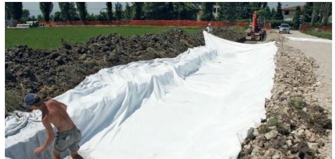
② 準備 砂または細かい砂利を敷き底を平らにした後、ジオテキスタイルを敷設
