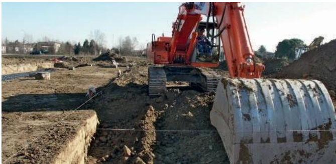
① 掘削 設計通りに掘削
