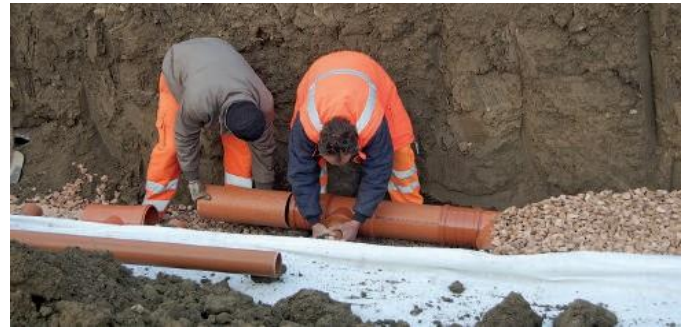
④ 接続 給排水管を水槽に接続
