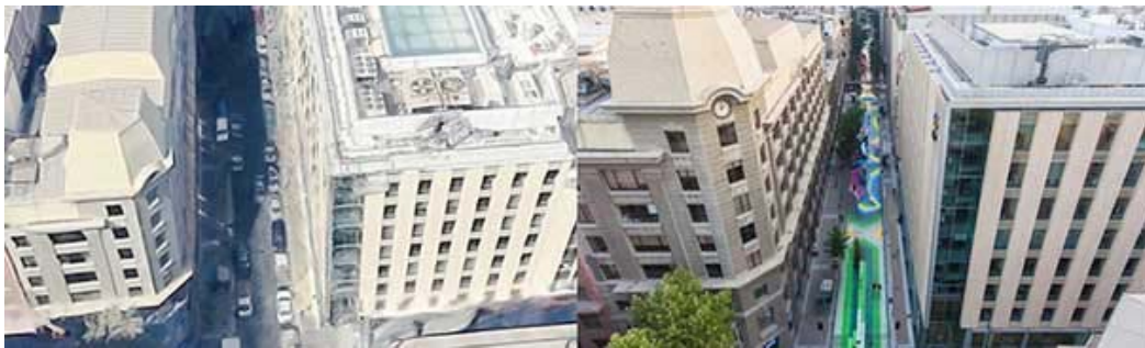
Figura 2. Antes y después de la intervención en la calle Bandera. Fuente: Google Earth 2012 y 2019
