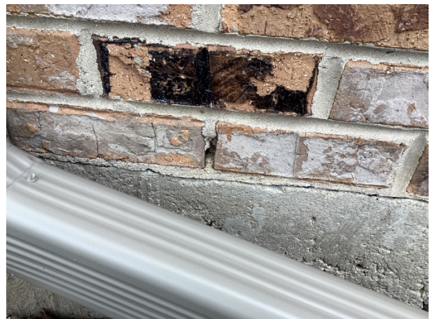
Mortar spall
