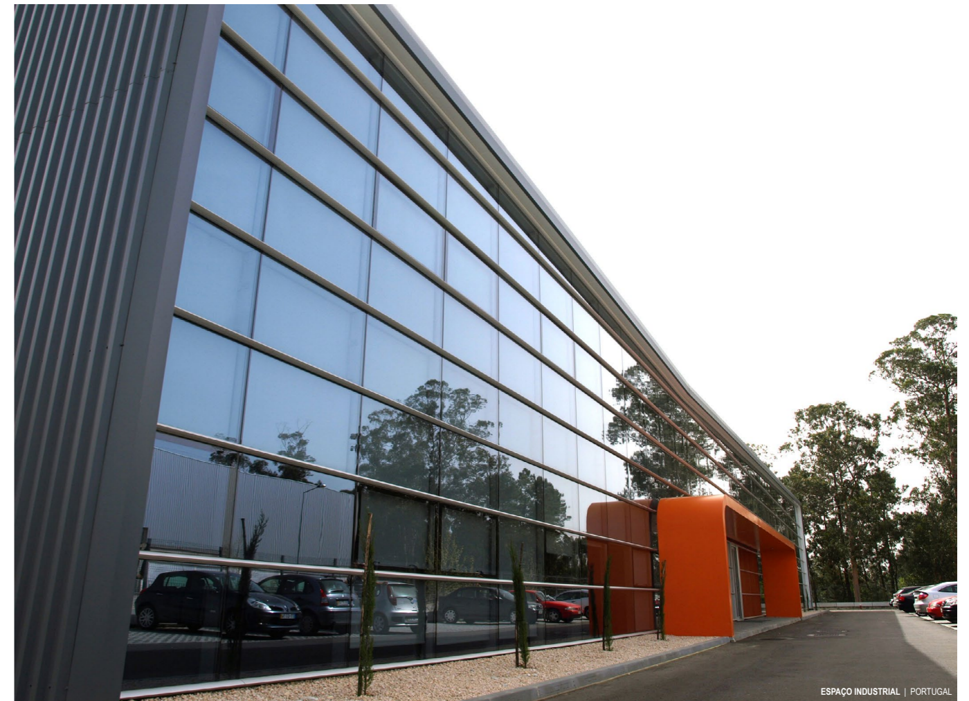
ESPAÇO INDUSTRIAL | PORTUGAL
