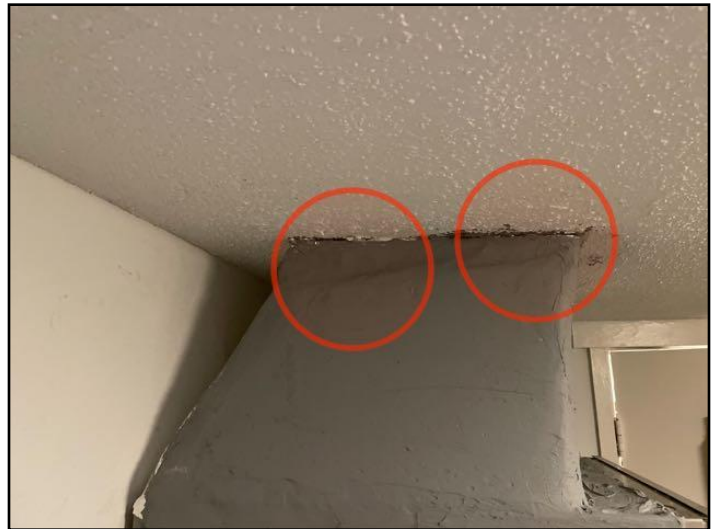
30. Loose/Missing Tape
