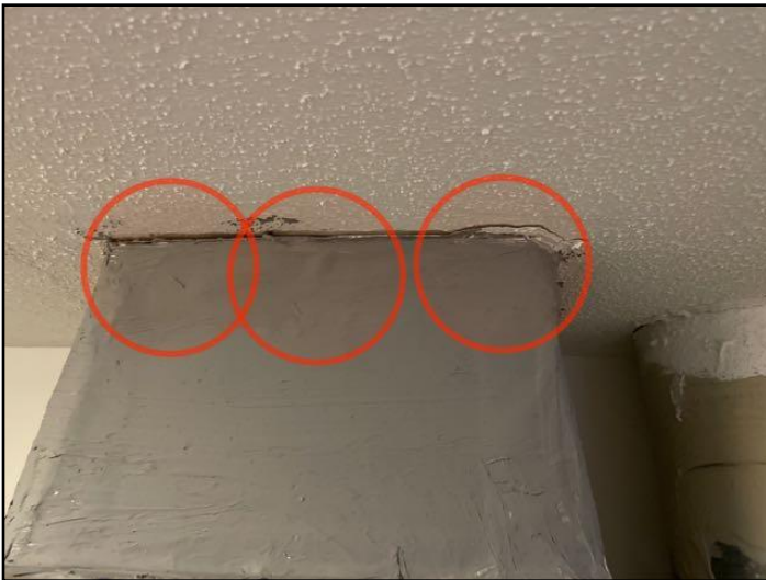
29. Loose/Missing Tape
