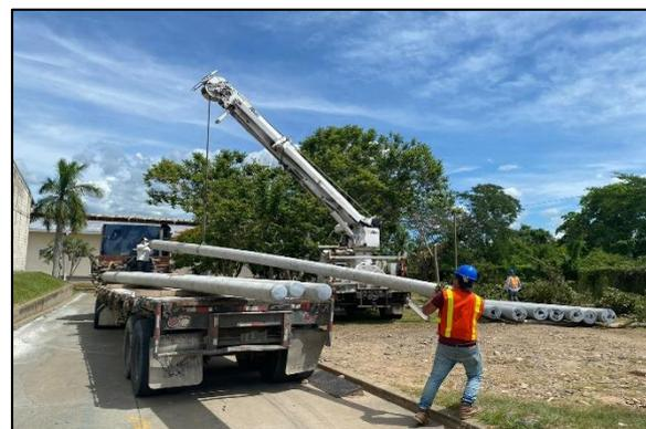
**Diseño y construcción de red media tensión Doble Terna con cable 556 ACCR 34.5 KV**
