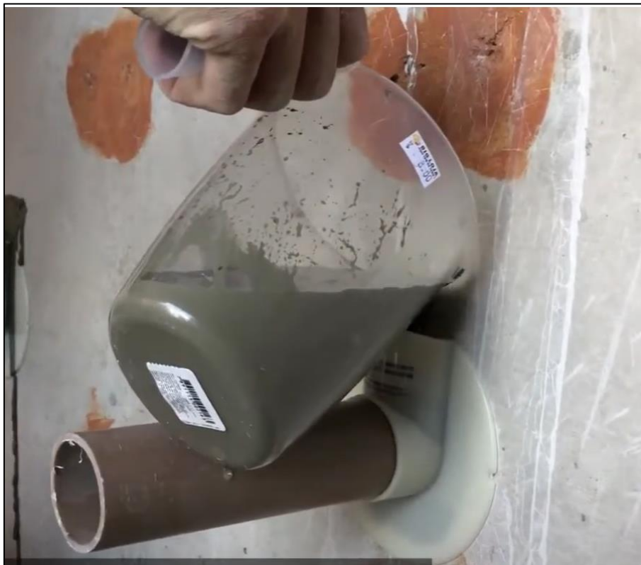
Figura 11 - Despeje o graute com auxílio de uma jarra devagar
