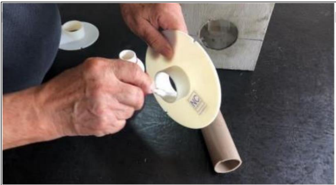
Figura 5 - Aplique cola de PVC na luva interna do flange
