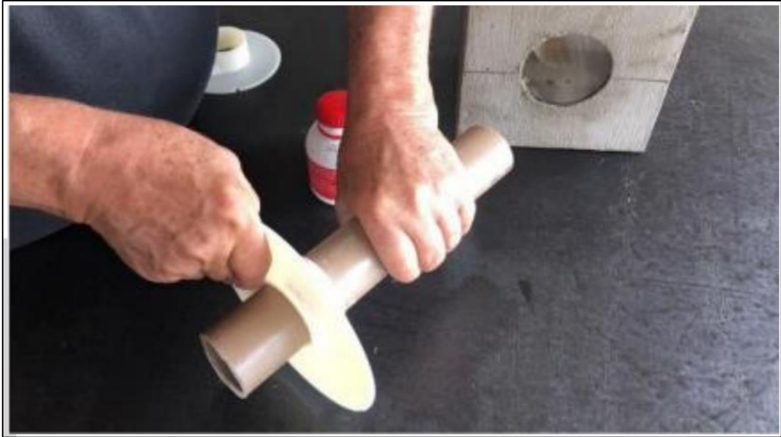
Figura 6 – Fixe o flange "A" na tubulação com a luva voltada para dentro
