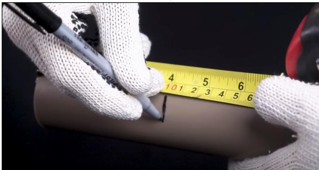
Figura 3 - Realize a marcação na medida da tubulação, sendo o mínimo de 10cm.
