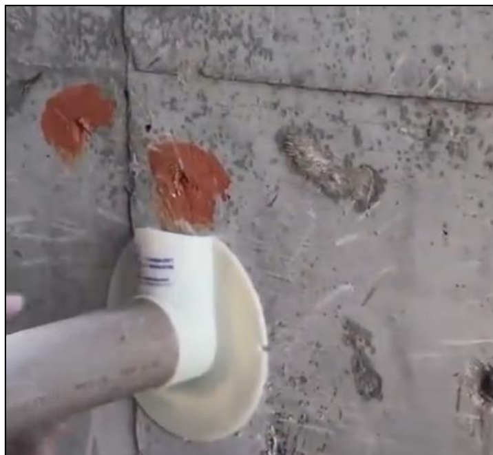
Figura 10 - Posicione o flange “B” com o cachimbo voltado para cima
