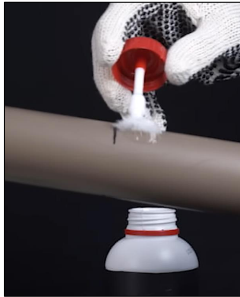
Figura 4 - Aplicação de cola de PVC na tubulação
