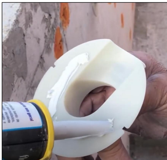
Figura 9 - Aplicação de PU na face interna do flange “B”
