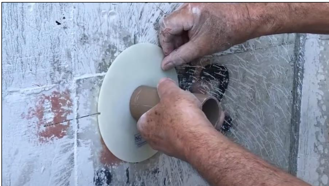
Figura 8 - Fixe o flange A na parede
