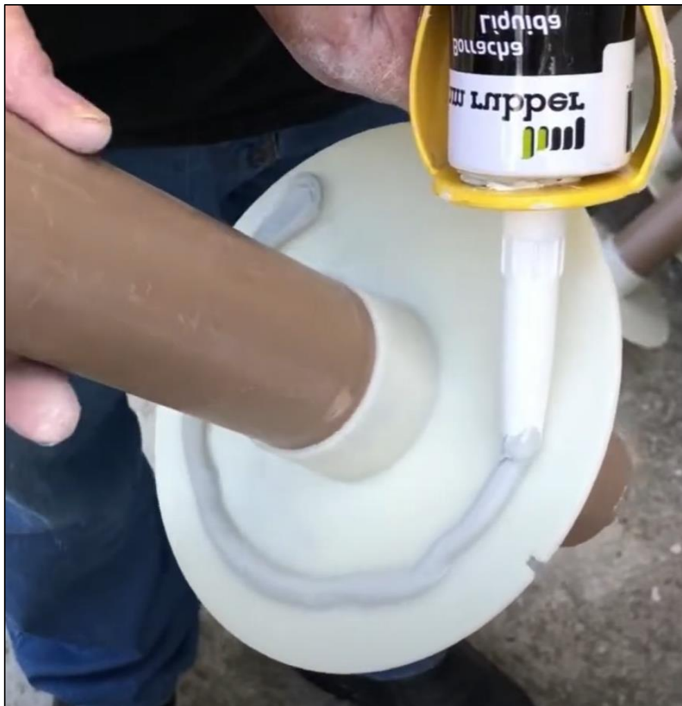
Figura 7 - Aplicação de PU no flange "A"
