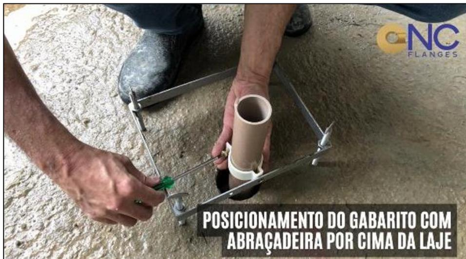
Figura 5 - Posicionamento e fixação do gabarito por cima da laje
