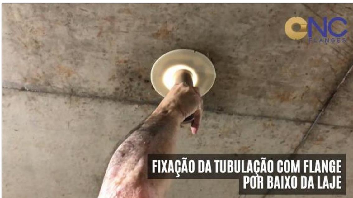
Figura 4 - Posicionamento do Flange "A" no furo por baixo da laje
