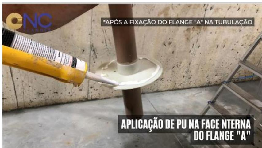
Figura 3 - Aplicação de PU no Flange "A"
