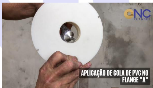
Figura 2 - Aplicação de cola de PVC no Flange "A"
