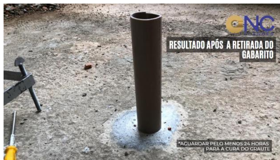
Figura 7 - Tubulação vertical grauteada
