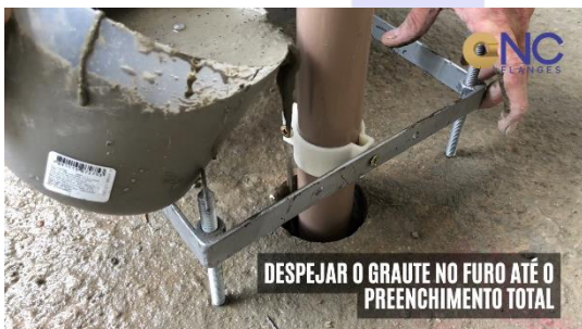
Figura 6 - Grauteamento do furo
