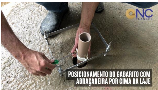
Figura 5 - Posicionamento e fixação do gabarito por cima da laje
