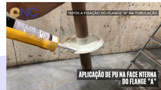
Figura 3 - Aplicação de PU no Flange "A"
