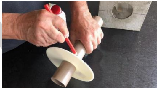
Figura 2 - marcação na medida da tubulação
