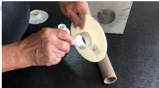
Figura 4 - aplicação de cola de pvc na luva interna do Flange “A”
