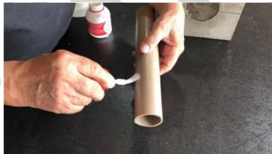
Figura 3 - aplicação da cola de pvc na tubulação
