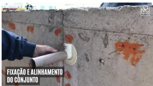
Figura 9 - posicionamento do Flange "B" na tubulação pelo lado externo do reservatório.
