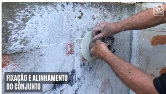
Figura 7 - fixação e alinhamento da tubulação e flange "A" no centro do furo
