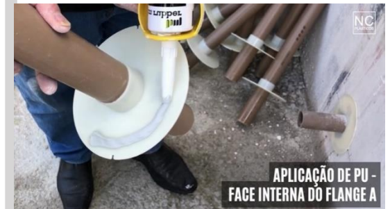
Figura 6 - aplicação de PU no flange “A”
