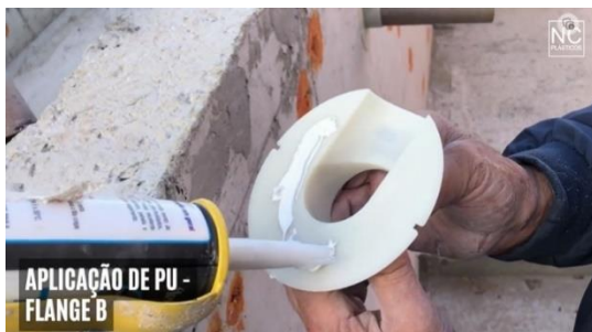
Figura 8 - aplicação de PU na face interna do flange "B"
