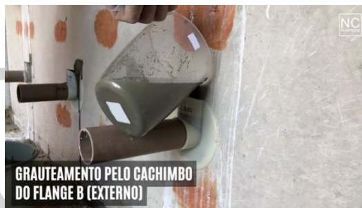
Figura 7 - grauteamento do furo pelo cachimbo do Flange "B"
