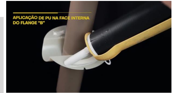
Figura 5 - aplicação de PU no flange “B”
