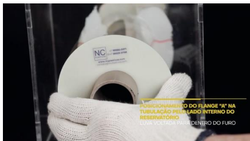
Figura 9 - posicionamento do Flange "A" pelo lado interno do reservatório, com o chanfro voltado para dentro do furo
