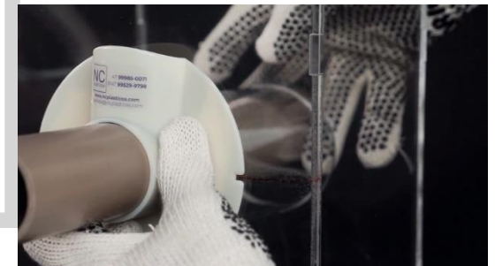
Figura 7 - fixação e alinhamento da tubulação e flange “B” no centro do furo
