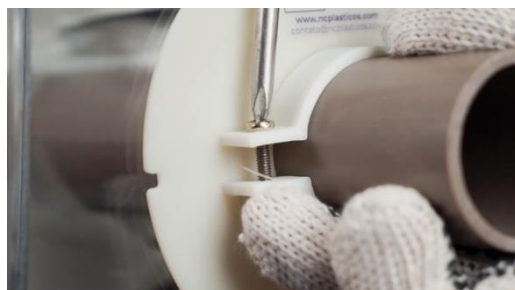
Figura 10 - posicionamento da abraçadeira na tubulação
