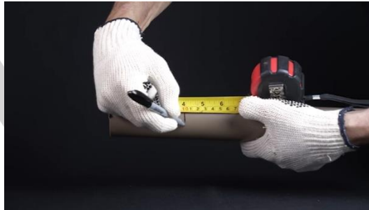
Figura 3 - marcação na medida da tubulação
