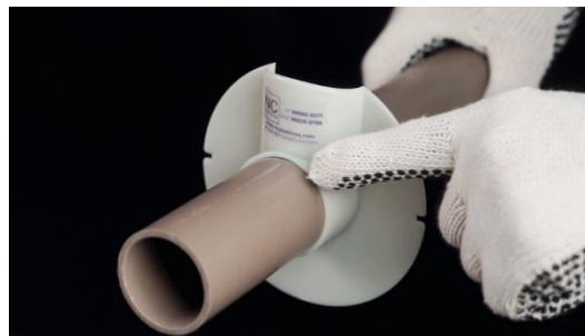
Figura 2 – fixação do flange “B” na tubulação
