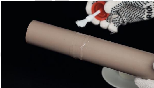
Figura 4 - aplicação da cola de pvc na tubulação
