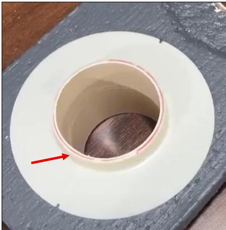
Figura 2 - Flange tubo emergente com a luva soldada na tubulação virada para cima (seta em vermelho demonstra a luva).
