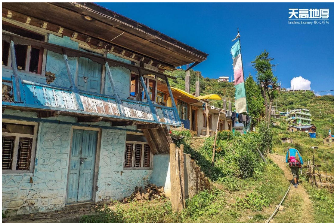
图罗.夏布鲁村里有不少在地震中受损废弃的房屋
