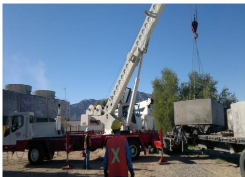
Grúa Hidráulica Link Belt 35,000 kg.
