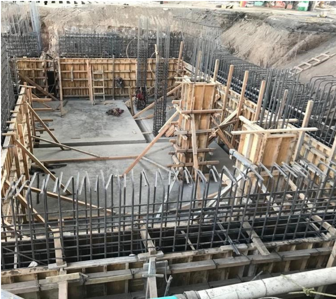
Armado y Cimbra de Muros de concreto armado en fondo de sótano.
