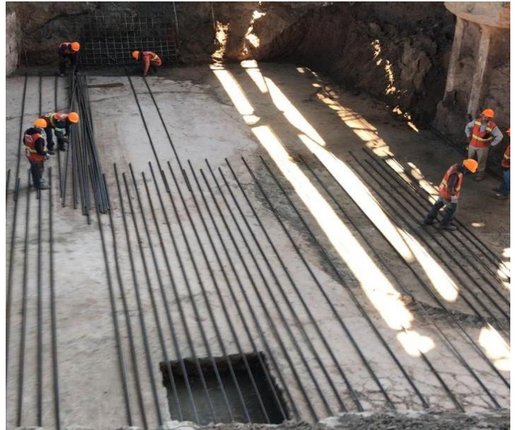
Armado de losa de cimentación en área de Tren de Laminacion.
