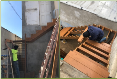
Joshua y Sammy Everett construyendo escaleras para German
